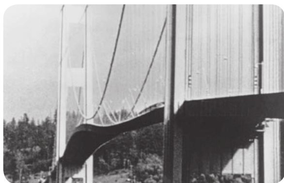
▲ A destruição da ponte do rio Tacoma (Washington, Estados Unidos) é um bom exemplo de ressonância. Inaugurada em 1º de julho de 1940, foi destruída quatro meses após, por vibração provocada pelo vento.
