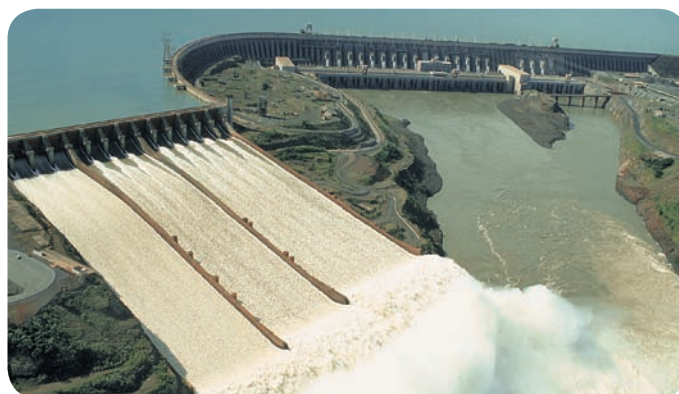
Usina hidrelétrica de Itaipu (Paraná), exemplo de central de geração de energia elétrica. Na foto, em primeiro plano vê-se o vertedouro, por onde a água escoia do reservatório (a montante da barragem) para a saída de água (a jusante), controlando o desnível. Esse controle é fundamental para o funcionamento da usina.
